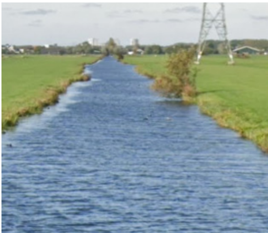
De brede sloot voldoet niet aan instapeisen en kan niet meetellen voor % groenblauwe dooradering
